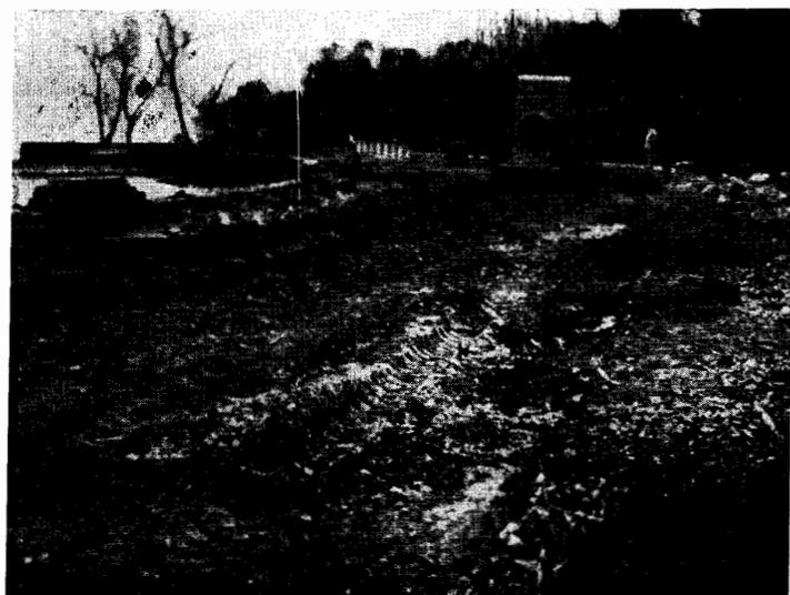
Fig. 8 - Motoniveladora reparando el camino para el paso de otras unidades necesarias para la reconstrucción de muros y pavimento.
